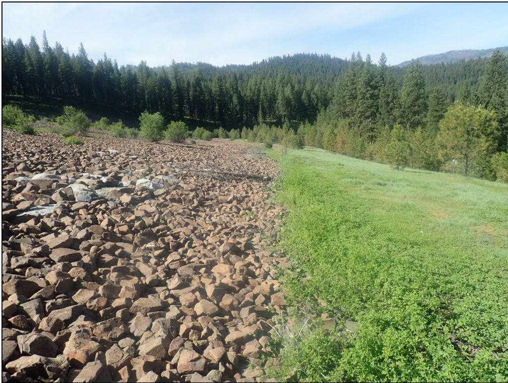
PL-4. Disposal Cell Apron
