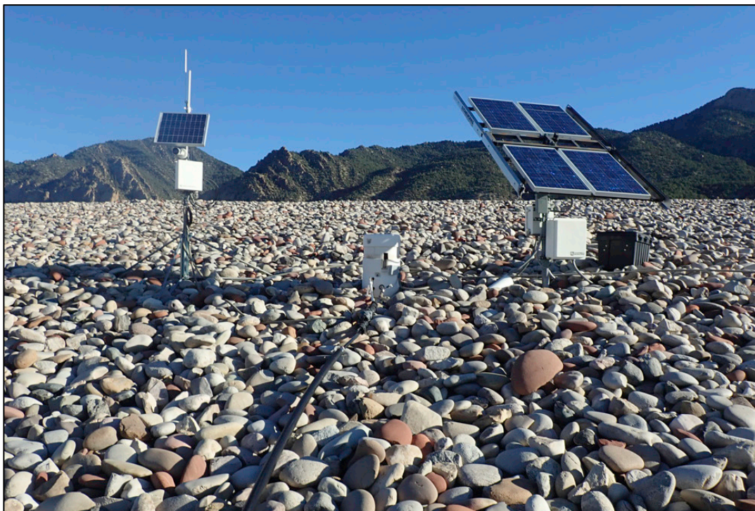
PL-6. Standpipe MW02
