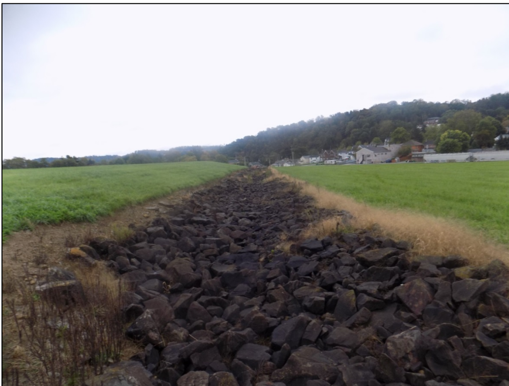
PL-8. Riprap-Armored Diversion Ditch
