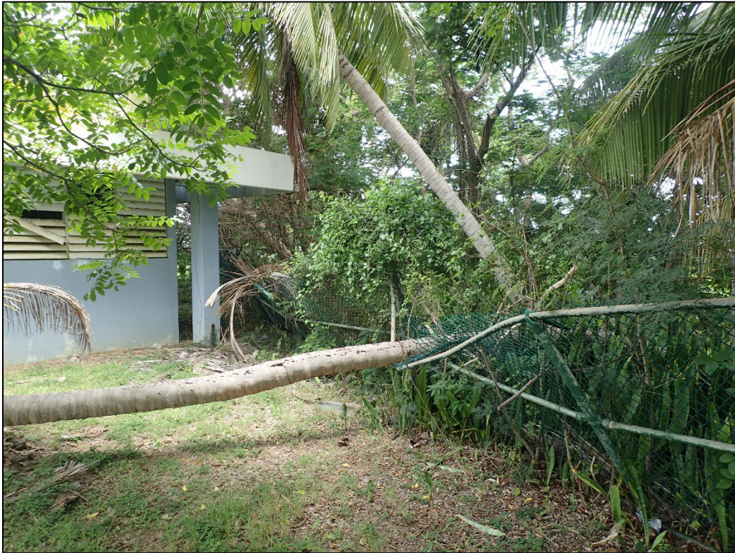
PL-7. Árbol caído sobre la verja del perímetro de seguridad
