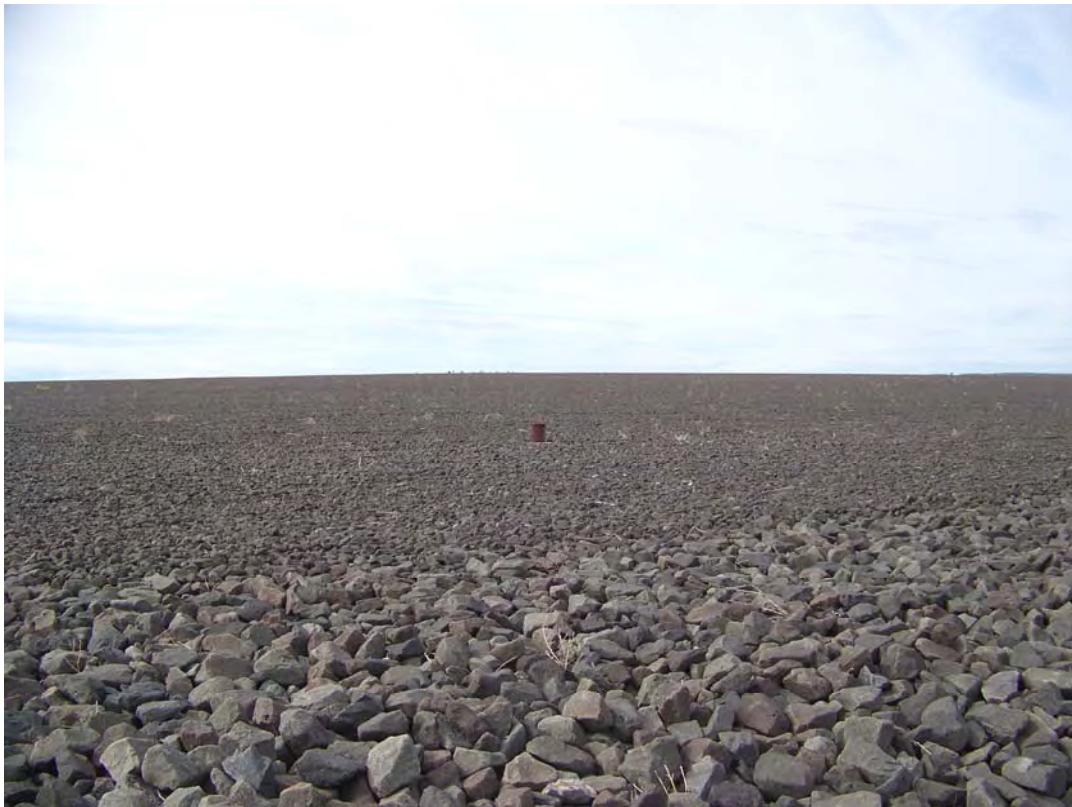
AMB 8/2008. PL-4. Repaired surface at settlement plate SP-4.
