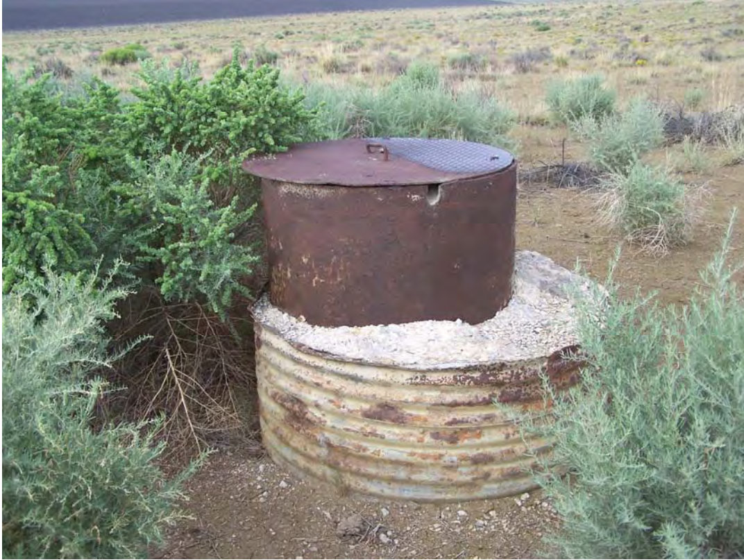
AMB 8/2008. PL-3. Concrete-filled vent shaft cover.
