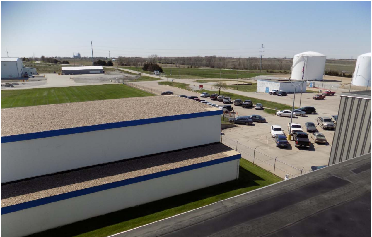
PL-3. West End of IHX Roof
