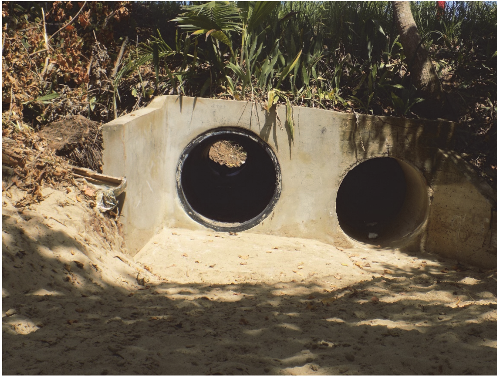
PL-8. Alcantarillas de drenaje
