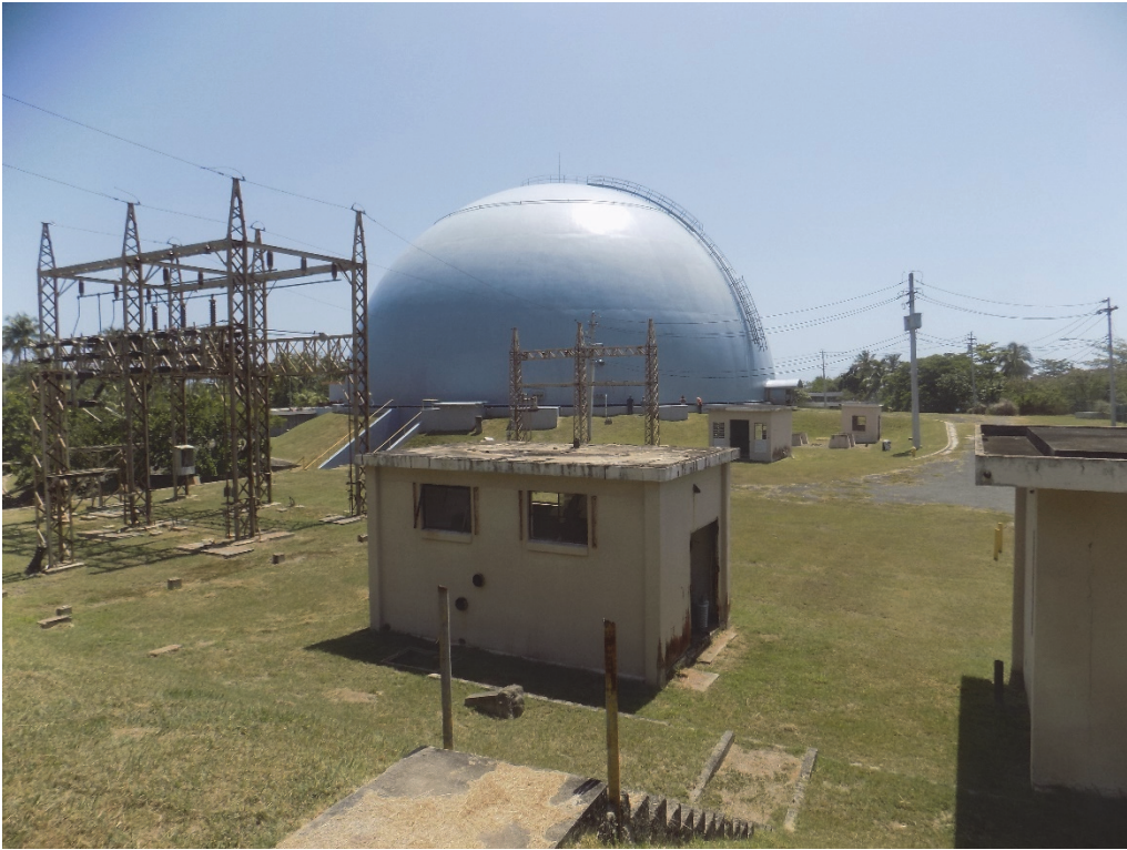
PL-6. Cúpula de contención
