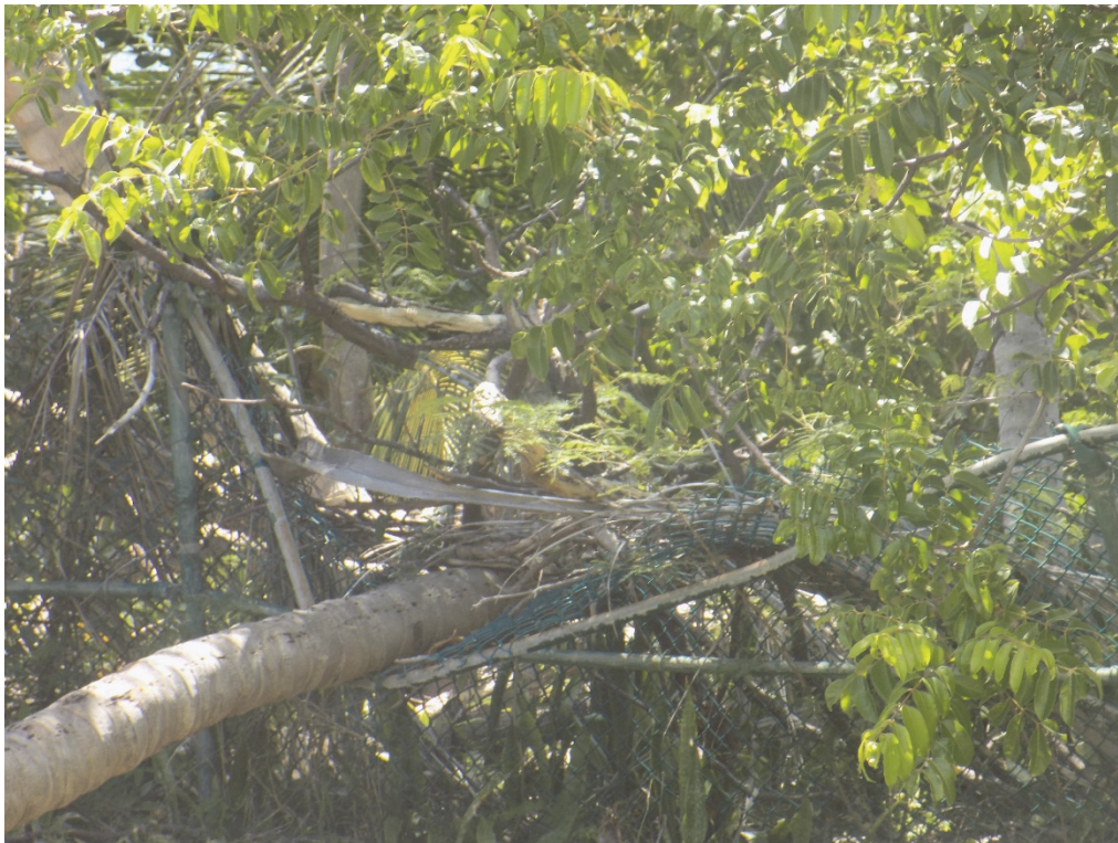
PL-3. Árbol caído sobre la verja de seguridad
