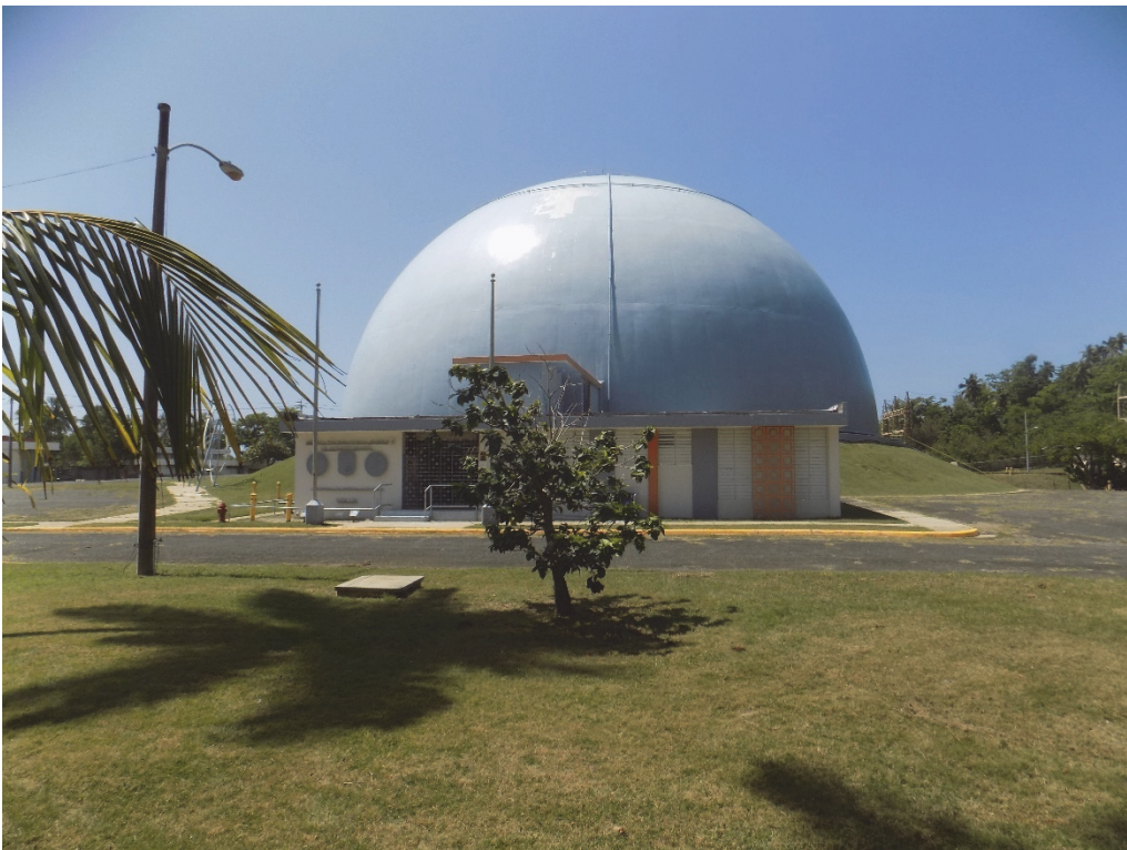
PL-7. Cúpula de contención
