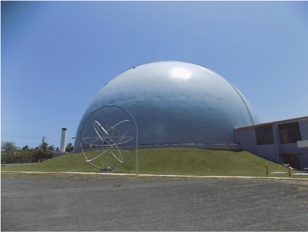
PL-1. Cúpula de contención
