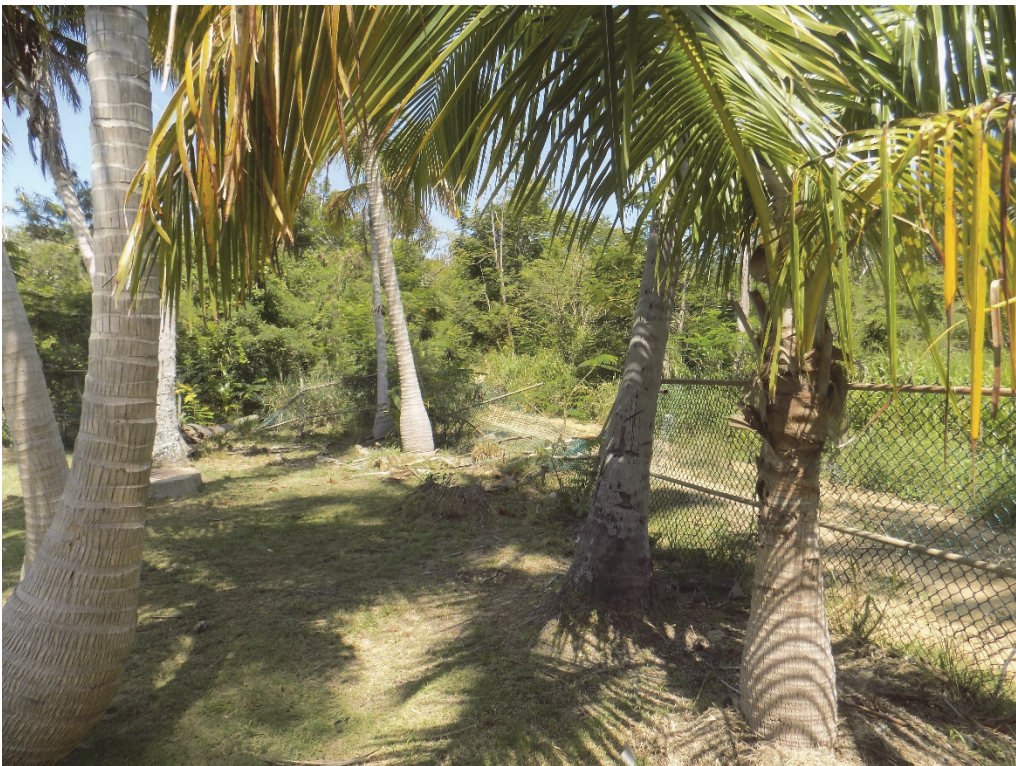
PL-8. Árbol caído sobre la verja de seguridad
