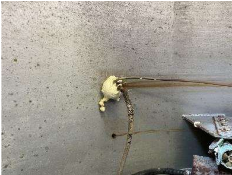
PL-1 Abertura sellada en la Esclusa de Aire 2
