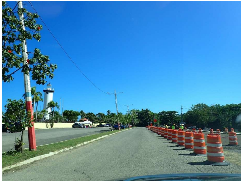
PL-9 Construcción frente al faro
