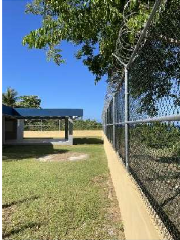
PL-8 Nuevo muro de contención y verja
