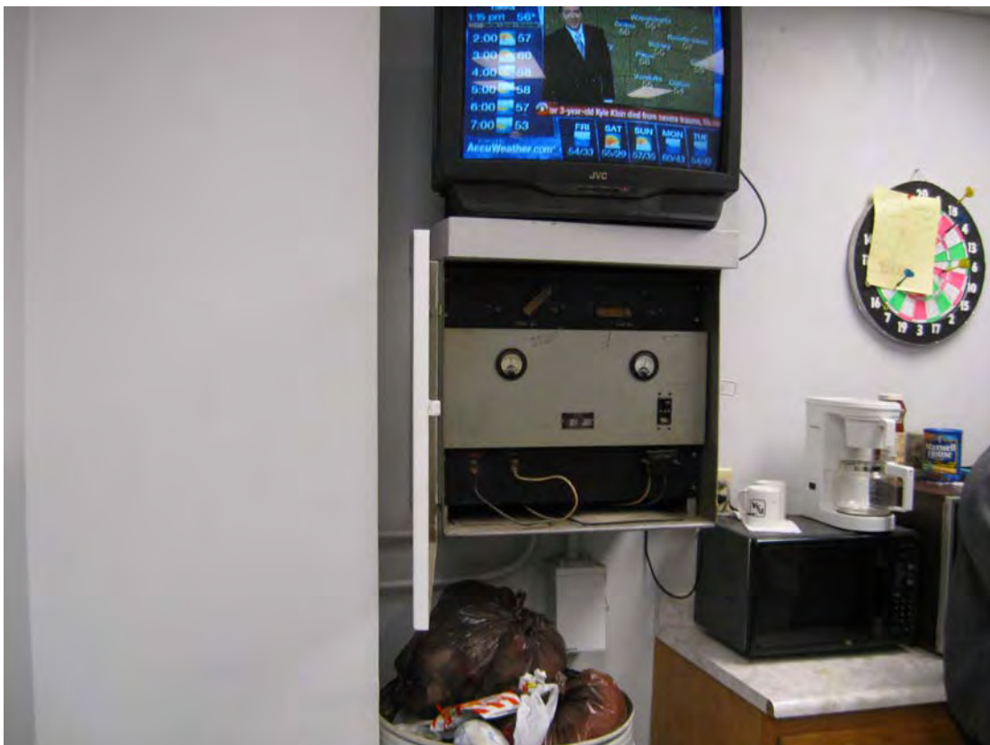
PIQ 4/2009. PL-14. Rectifier control unit
