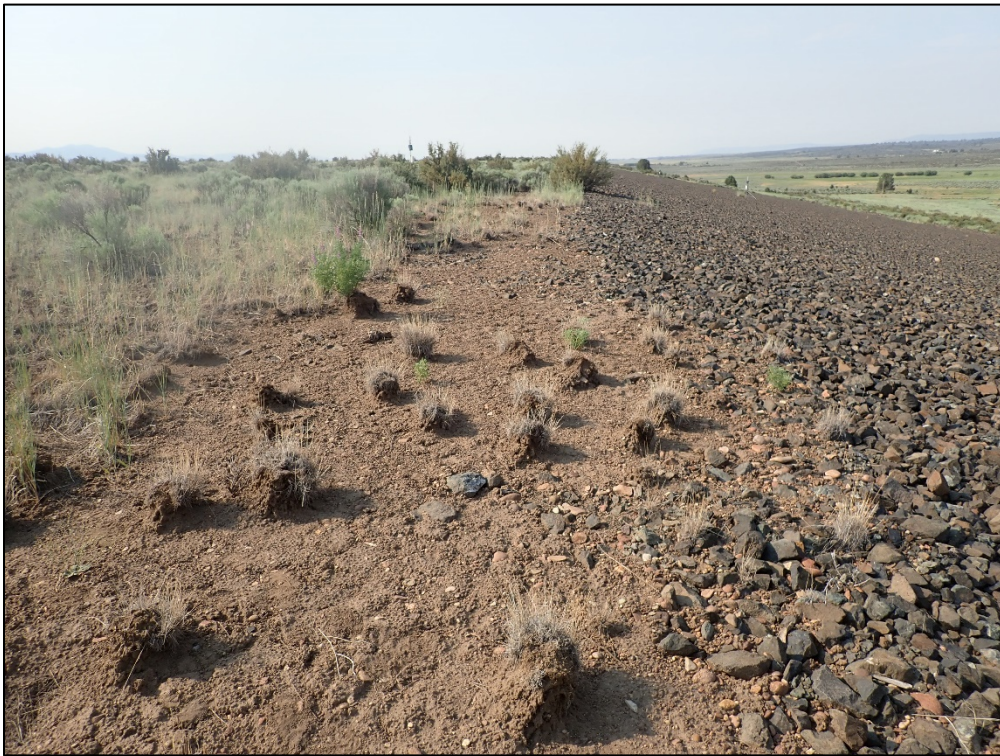
PL-8. Top Edge of West Side Slope
