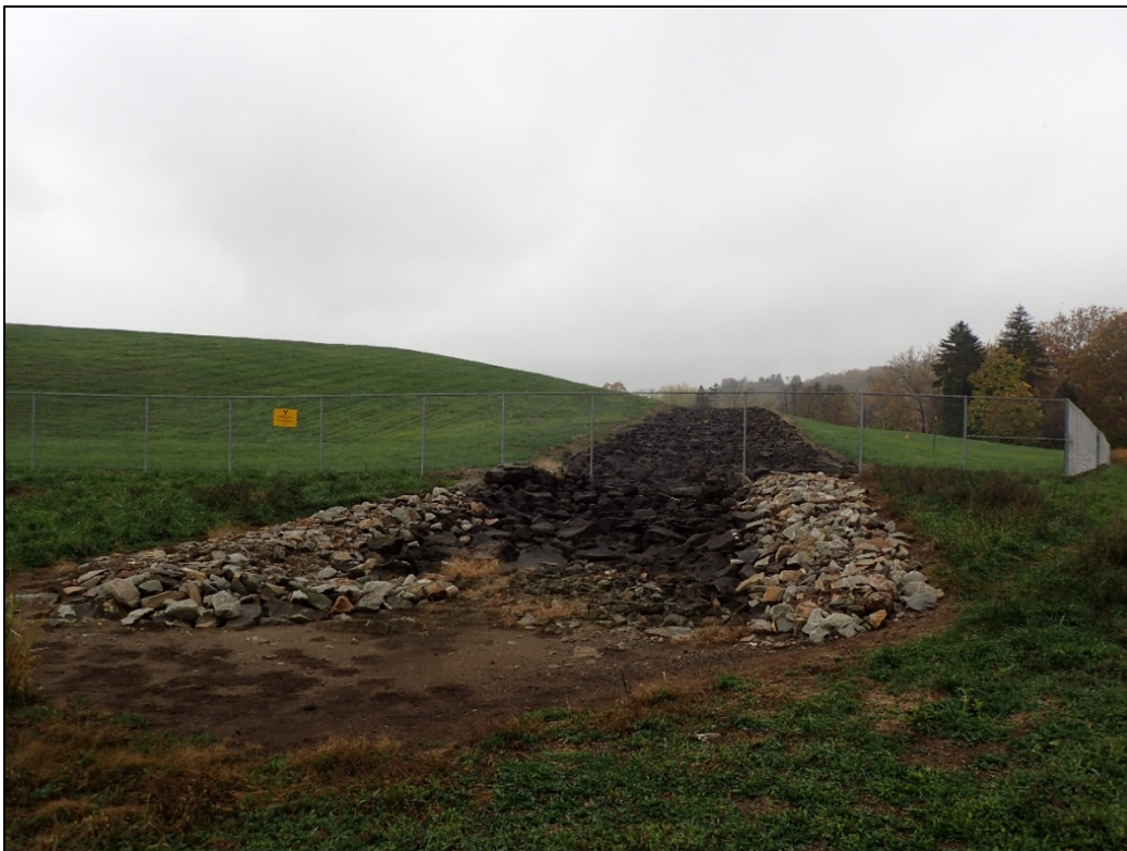
PL-8. Riprap Diversion Ditch Outlet
