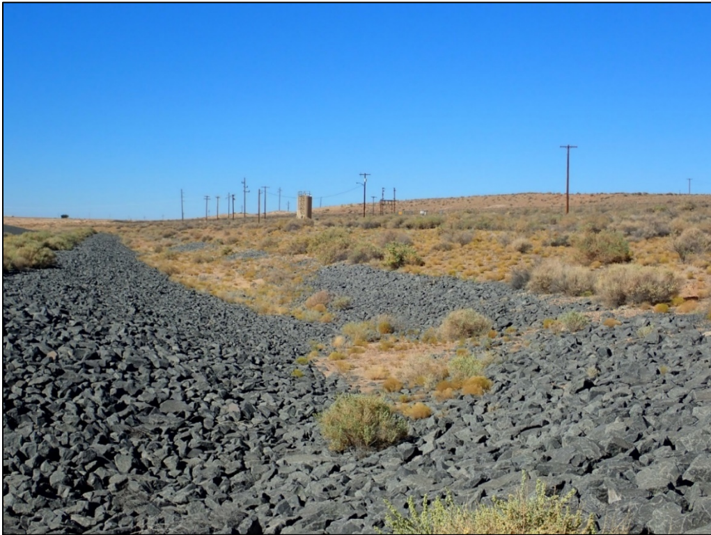
PL-8. Diversion Channel
