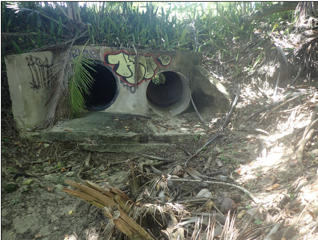
PL-9. Drain Culvert
