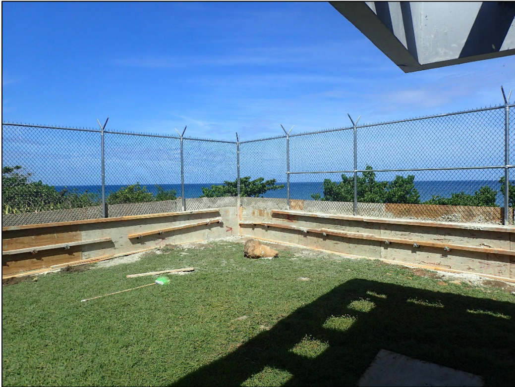
PL-7. Nuevo muro y verja del perímetro
