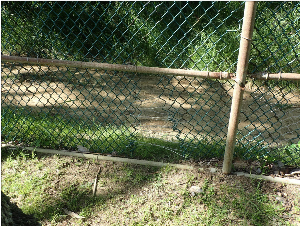
PL-5. Reparación de la verja del perímetro
