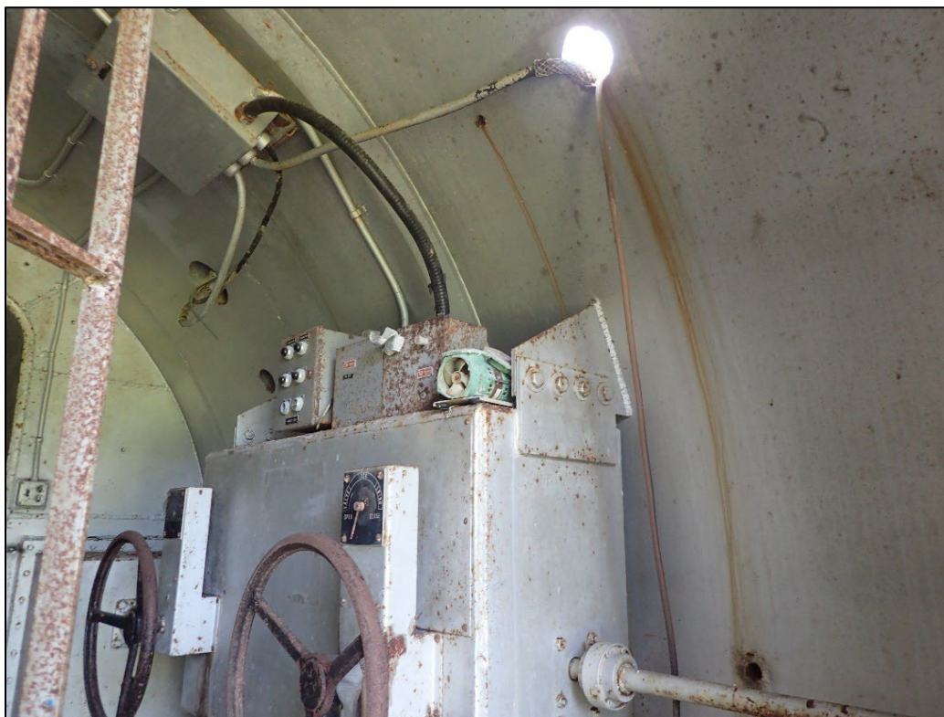
PL-1. Abertura al exterior en la Esclusa de Aire 2
